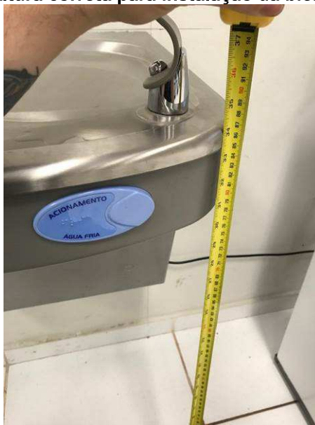
Imagem 29 – Altura correta para instalação da bica do bebedouro
